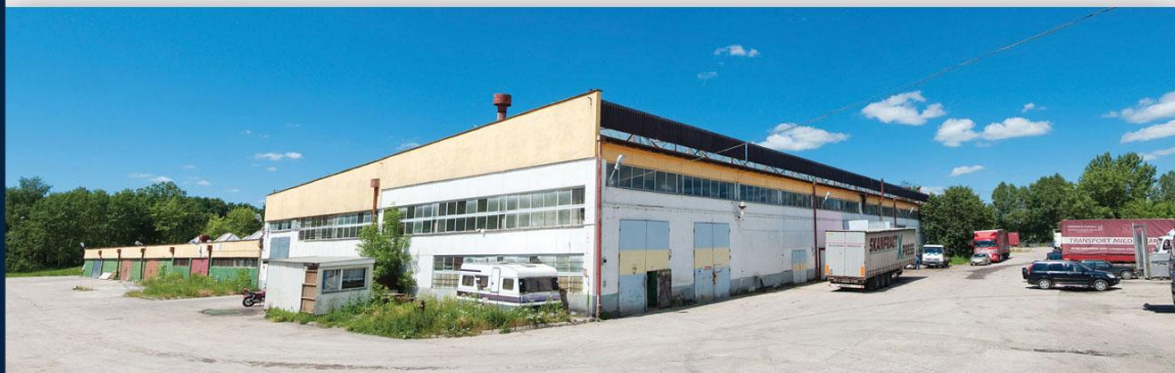
Widok na hale wysokiego składowania
