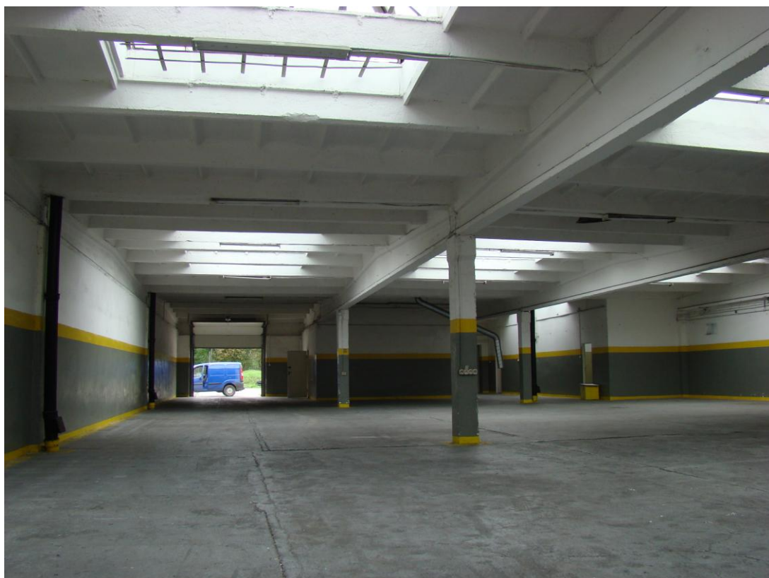
Fot. 10 Hale środkowej części magazynowej o wysokości do 3-3,75 m – 4750 m 2
