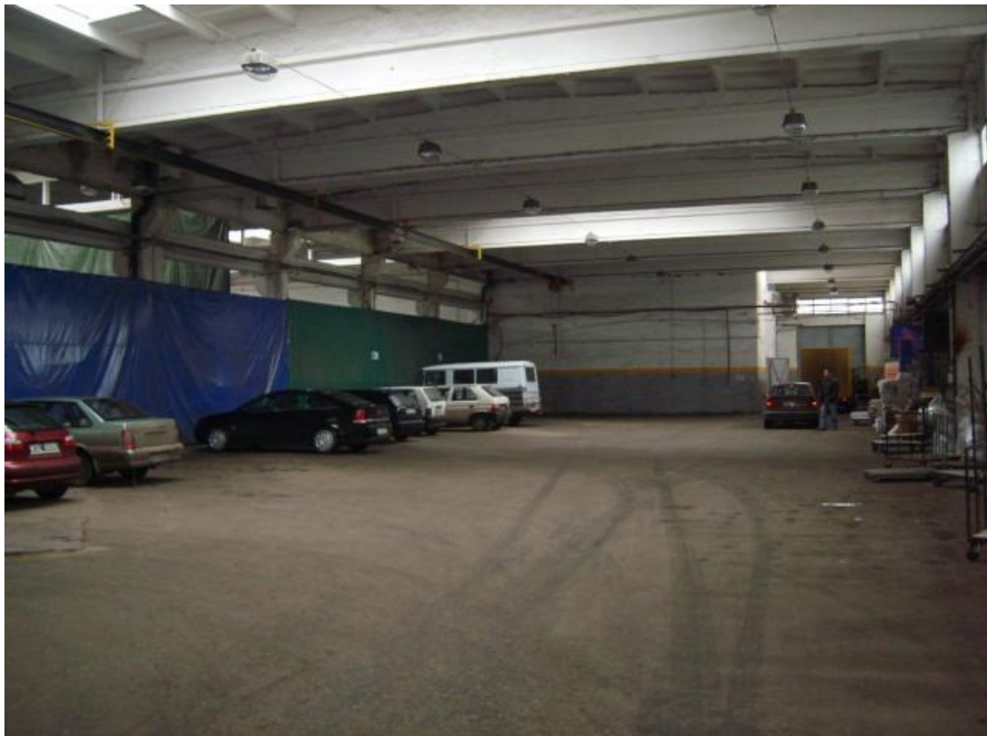
Fot. 7 Hala Wysoka – nawa II o wysokości 7,50m , szerokości 18,30m i długości 78,80 m
