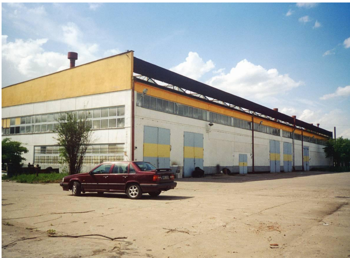
Fot. 5 Fragment wysokiej części magazynowo - produkcyjnej – c.a. 3000 m 2
