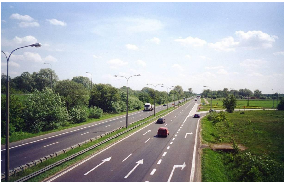
Fot. 1 Widok z wiaduktu skrzyżowania bezkolizyjnego przed Nowym Dworem Mazowieckim, z drogą nr 579 Nowy Dwór Mazowiecki – Kuzuń - Błonie
