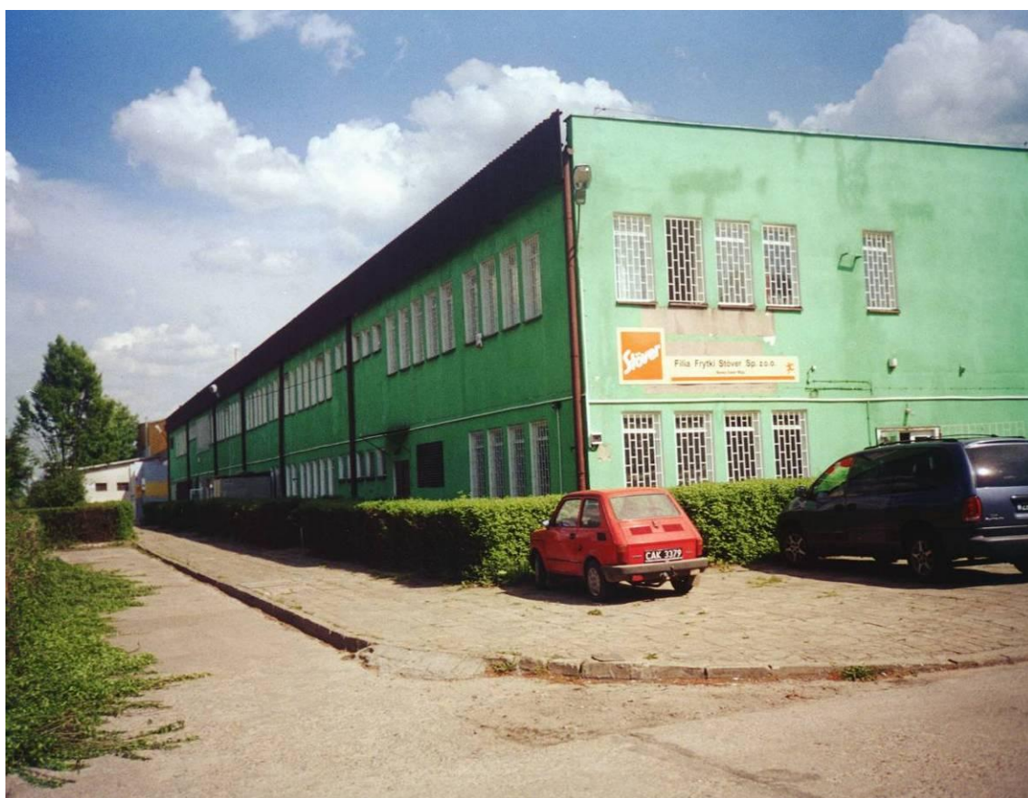
Fot. 4 Fragment części biurowo-socjalnej obiektu – c.a. 1750 m 2
