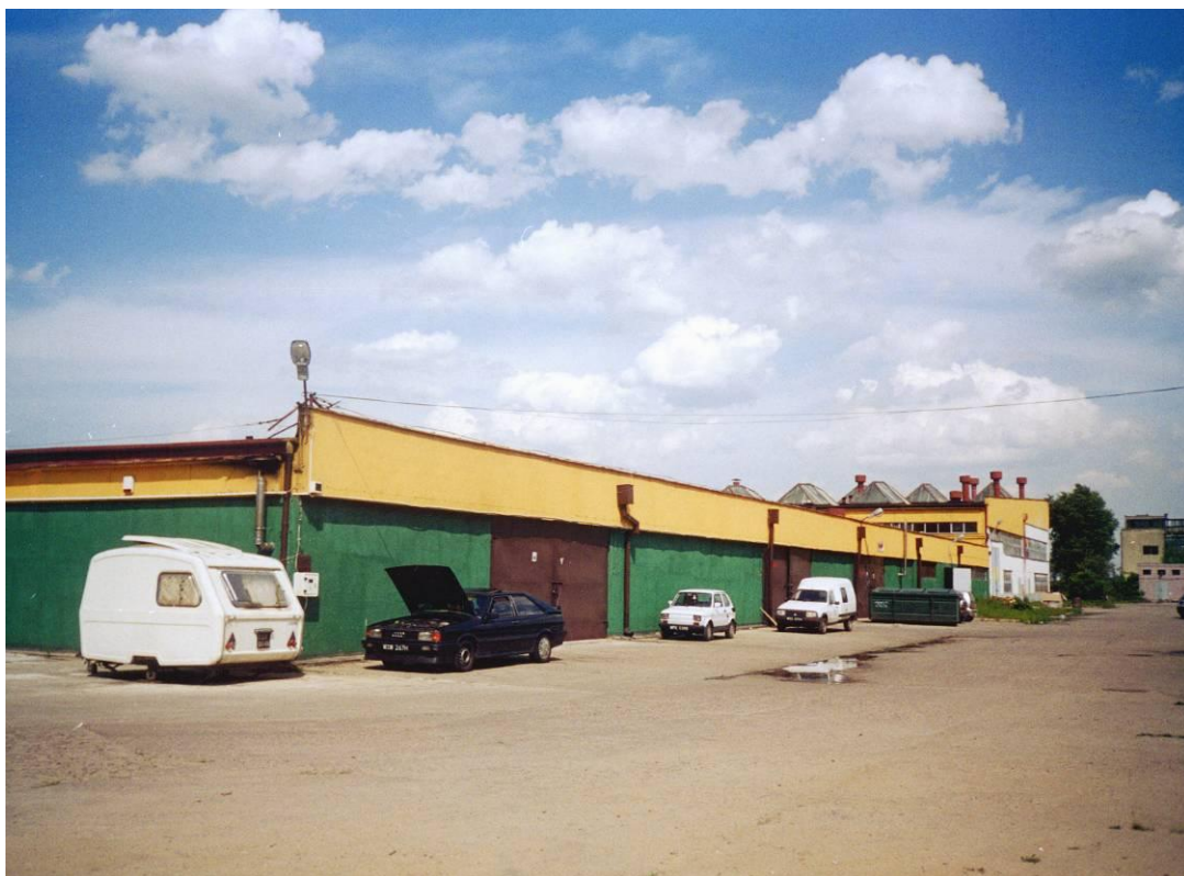
Fot. 9 Fragment środkowej części magazynowo-produkcyjnej o wysokości 3-3,75 m – siatka słupów 6x12m układają się w 6 pól o wymiarze 12x72 m lub 11 pól o wymiarach 6x66 m.
