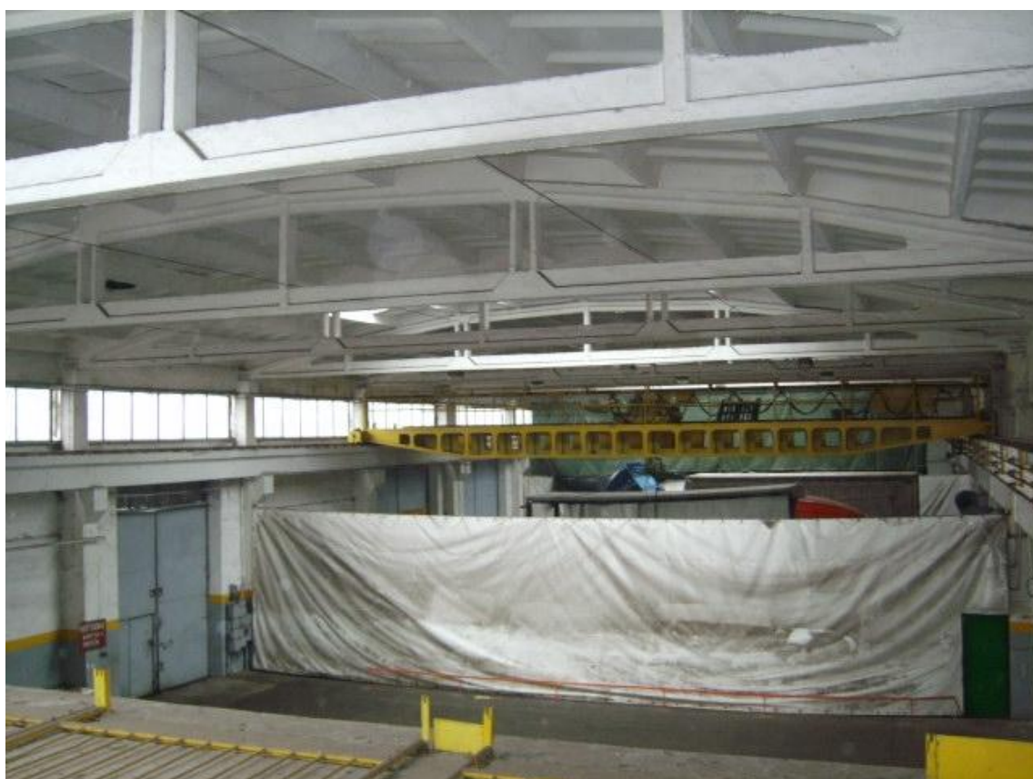
Fot. 6 Hala Wysoka-nawa I o wysokości 8,50m, szerokości 17,70m i długości 78,80m z suwnicą na całej długości hali o udźwigu 5 ton
